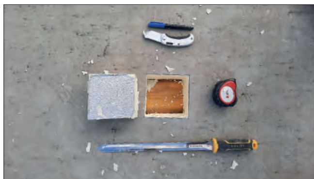
Рис. 3. Место отбора образца плит PIR из кровельного пирога Fig. 3. Sampling location of PIR-board samples from the roofing composition
