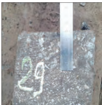
Рис. 2. Измерение толщины асфальтобетонного слоя дорожной одежды Fig. 2. Measurement of asphalt concrete pavement thickness
