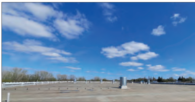
Рис. 1. Общий вид кровли на объекте для исследований (Республика Башкортостан)
